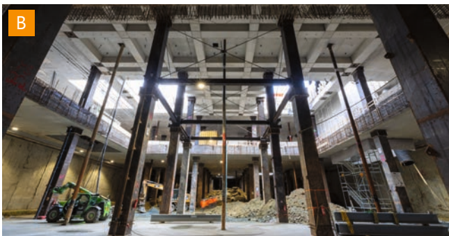
Foto: DB Netz AG/ARGE Marienhof
